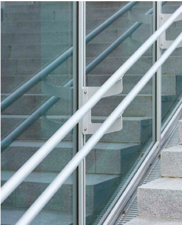
Exempel på infästning med dekorprofil Add.
